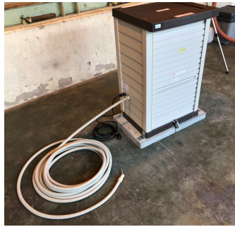
正面 (シャッター開時) 保護管 (電線管) 取付状況
